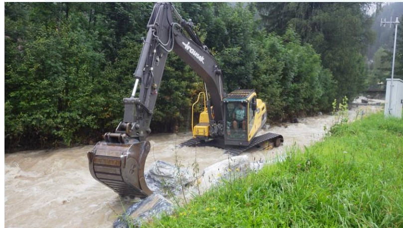
Entfernen gefährlicher Anlandungen im Unterlauf.
