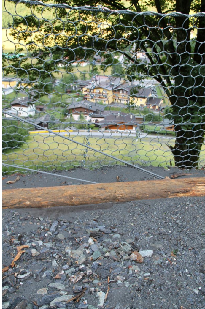
Die unmittelbar am Hangfuß situierte Siedlung konnte vor einer massiven Beschädigung bzw. Zerstörung zum wiederholten Mal geschützt werden
